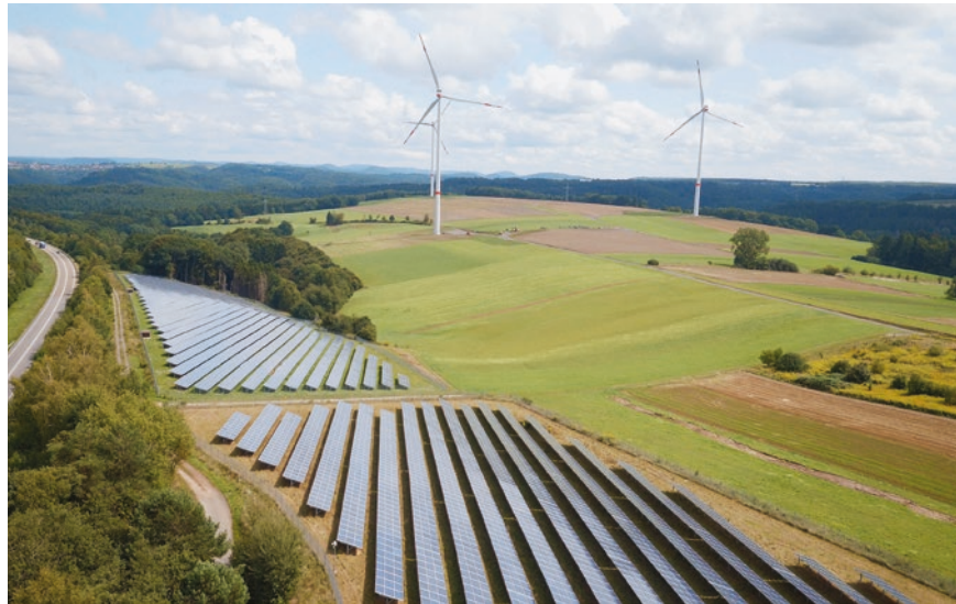
Nicht nur die Erzeugung von Strom wird zur Herausforderung: das ganze Energiesystem muss mit den vielen dezentralen Erzeugern und neuen Verbrauchern stabil gehalten werden.
